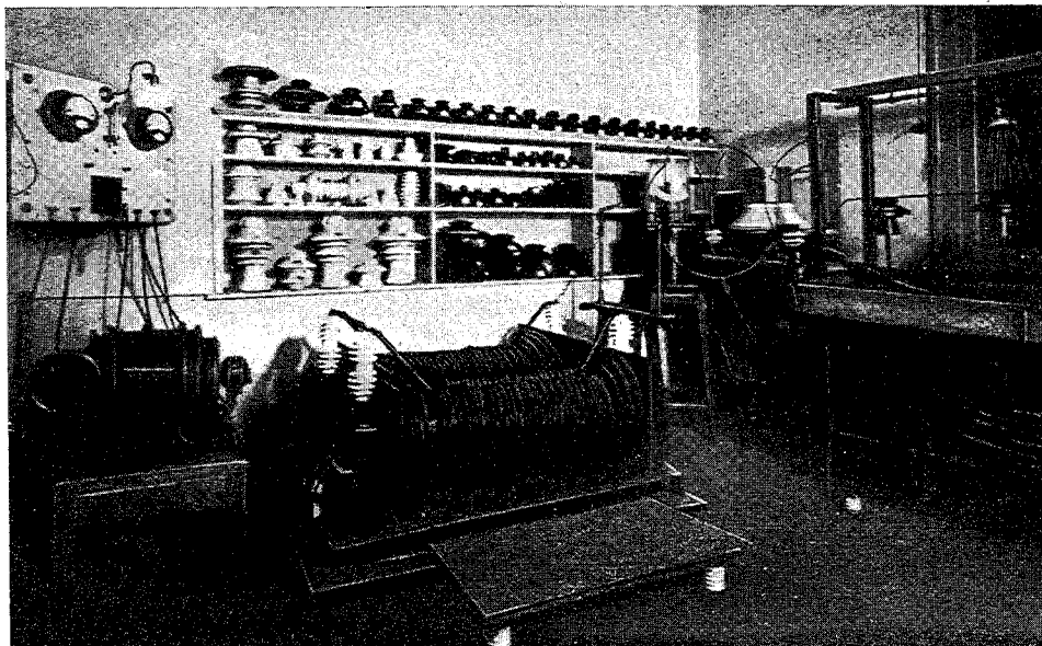
Sala alte tensioni del 1903
